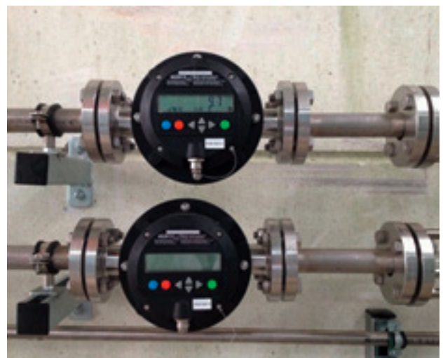
FMO 150 mit Flanschanschluss eingebaut in einer Rohrleitung.
